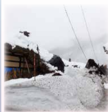
空き家の倒壊 水引
